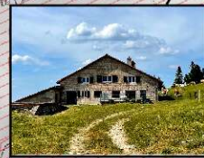
La Loge des Pradières-Dessus
